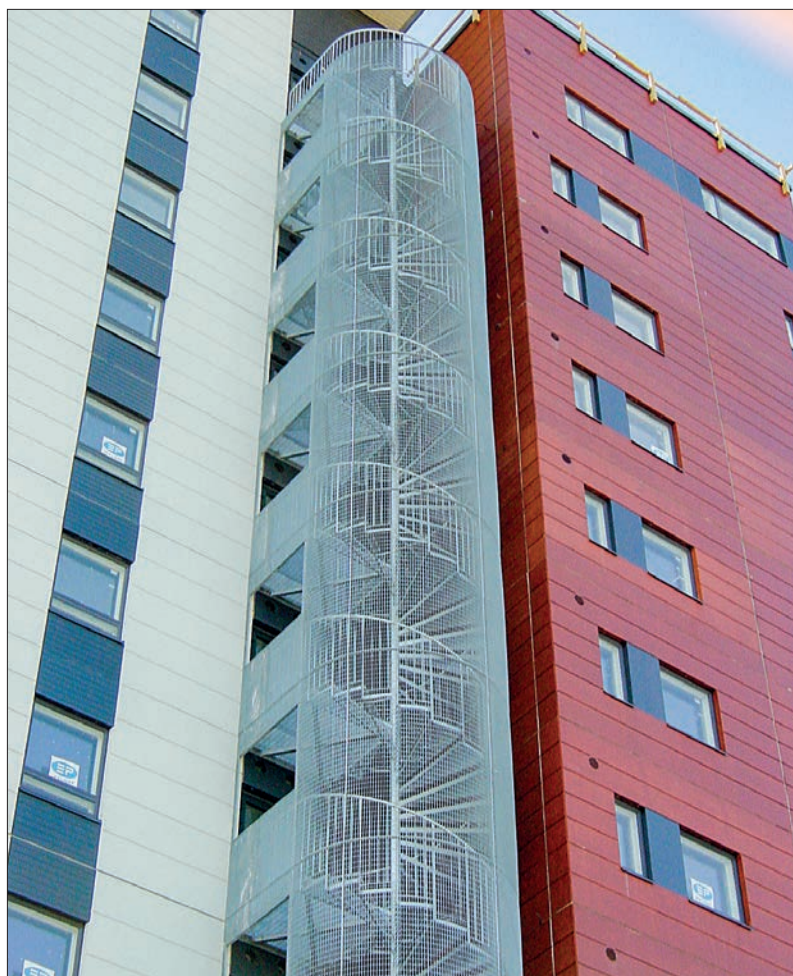
MP-uloskäytäväporras ja porrastorni rutilästä
