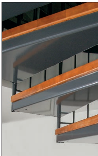
Kierreportaan puuaskelman teräsrunko alapuolelta nähtynä.
