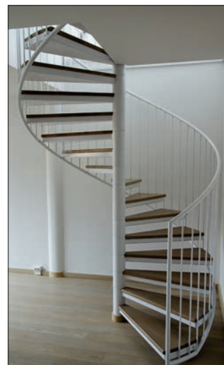
Täyspinnakaide on erikoisvalmistettu. Kaide on kehystetty putkella.
