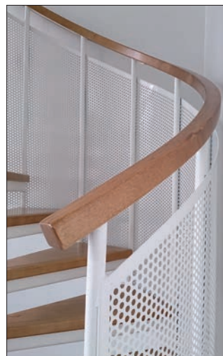
Kaiteen reikälevy on kehystetty U-listoin. Puukäsijohde on pyökkiä.
