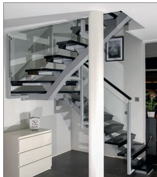
U-mallinen suoraporras yhdellä alapuolisella reisipalkilla.
